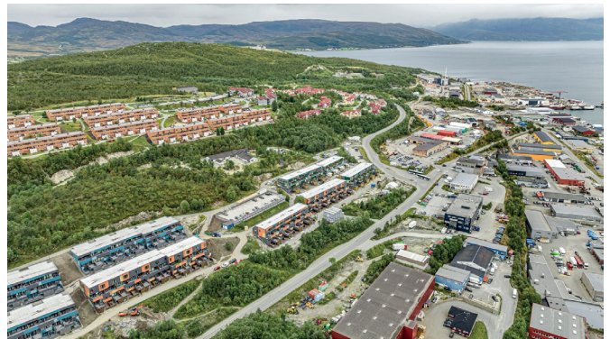
Eksisterende bygningsmasse. Bilde hentet fra Finn.no
