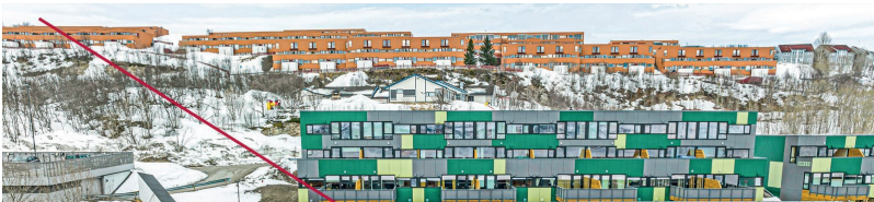
Eksisterende bygningsmasse. Bilde hentet fra Finn.no
