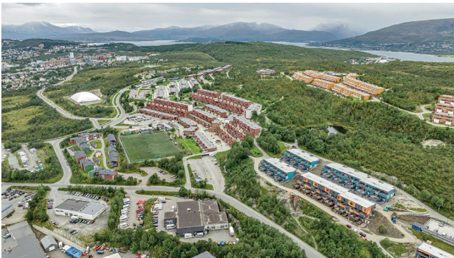
Eksisterende bygningsmasse. Bilde hentet fra Finn.no
